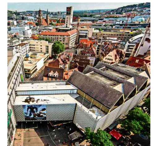
Die Giebelhäuser (re.) in der Eberhardstraße und der Überbau der Steinstraße beim Kaufhof sollen weichen. Foto: Lg/Piechowski
