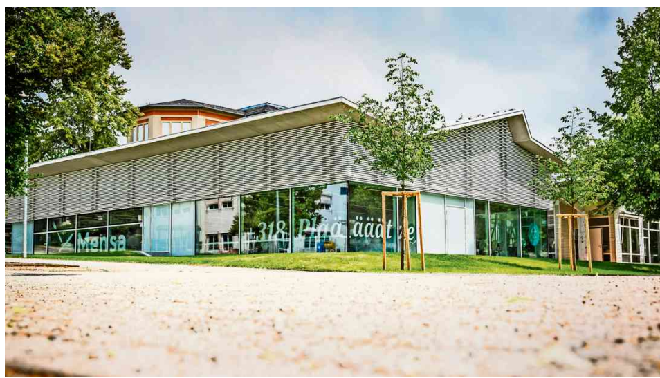
Unten viel Glas, oben viel Beton: der Neubau an der Mensa wirkt transparent und ansprechend. Er lädt ein zum Essen und zum Lernen. Fotos: Lichtgut/Julian Rettig
